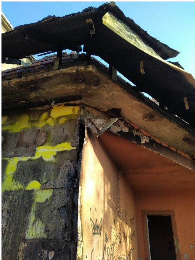
Požárem poškozená dřevěná konstrukce krovu a nosného obvodového zdiva
